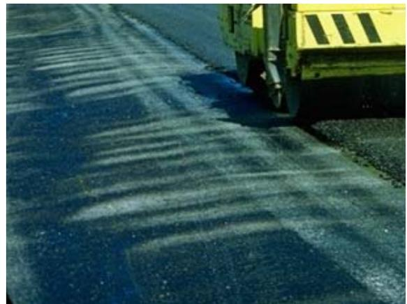
Foto 6. Defectos de un riego de adherencia ejecutado manualmente.
