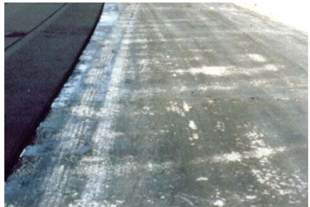
Foto aa. Defectos de un riego de curado por falta de protección.
