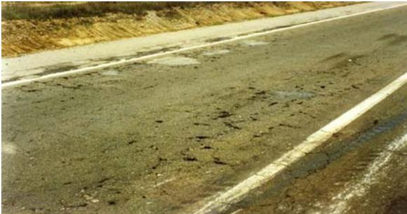
Fatiga debida a un mal comportamiento de la explanada (exceso de plasticidad y de humedad)
