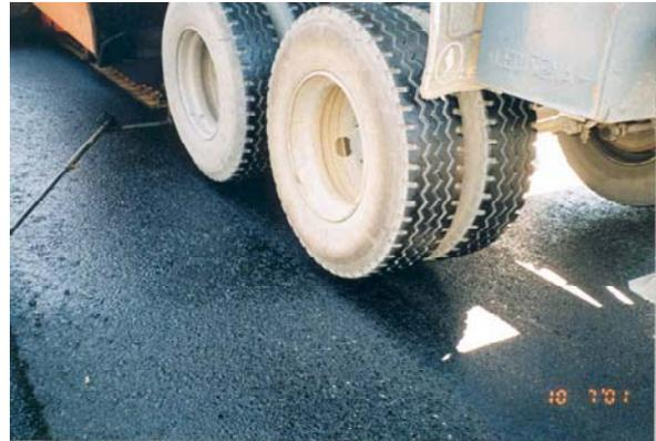
Aplicación de mezcla en caliente sobre emulsión termoadherente
