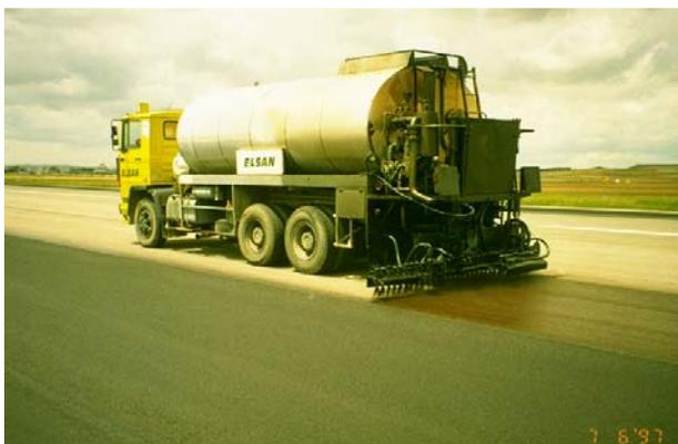
Foto 3. Aeropuerto. Riego de adherencia
