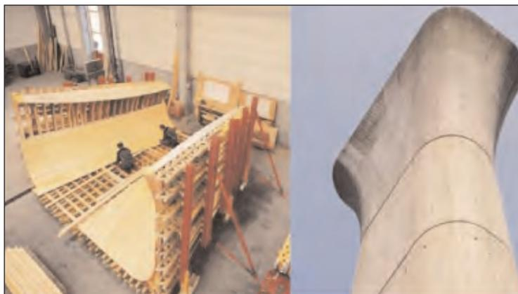
**Figura 3.5.8. Construcción de encofrado especial para cabeza de pila**
