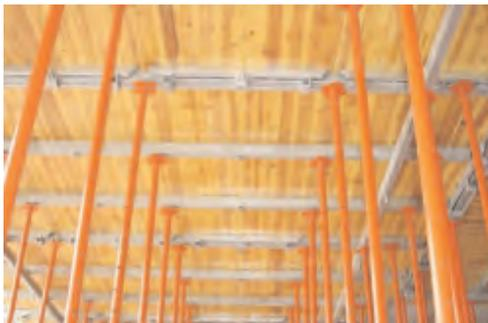
**Figura 3.5.3.67. Encofrado para forjado**
