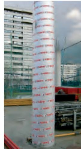
**Figura 3.5.3.26. Encofrado no recuperable (cartón plastificado) para pilares circulares**
