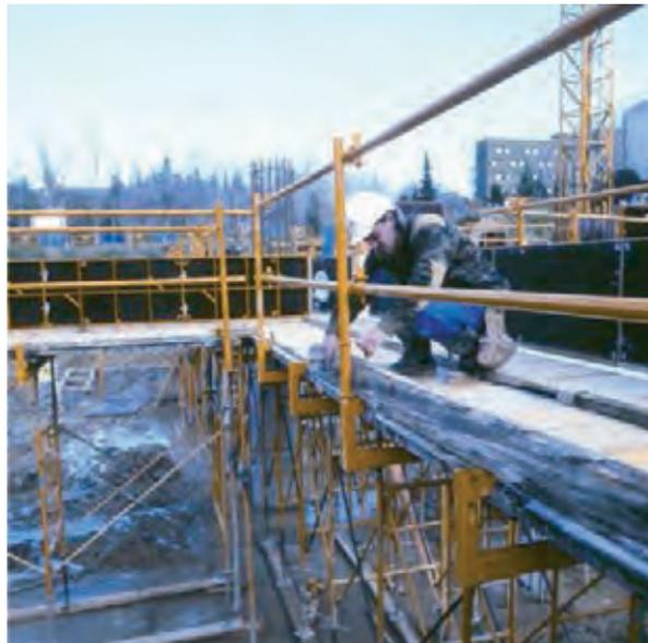
Figura 3.1.1.3. Anclaje por alojamiento en mecano de encofrado
