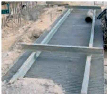
**Figura 3.1.4. Protección de hueco de batache**
