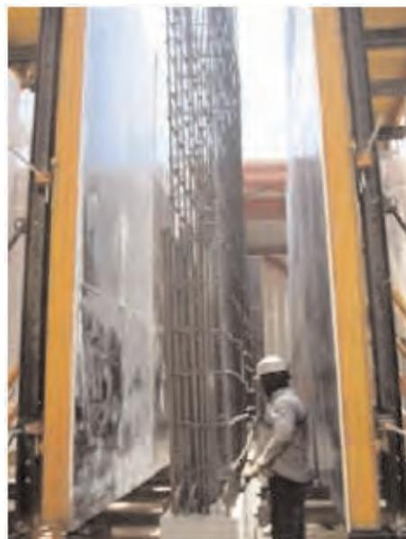
**Figura 3.5.3.62. Posicionamiento de armaduras en encofrado trepante de muro que dispone de sistema de retranqueo**
