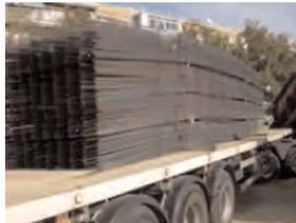
**Figura 3.6.6** Suministro de panel electrosoldado apoyado sobre tacos de madera
