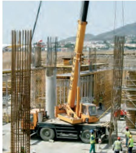
**Figura 3.5.3.21. Puesta en obra. Posicionamiento de armaduras**
