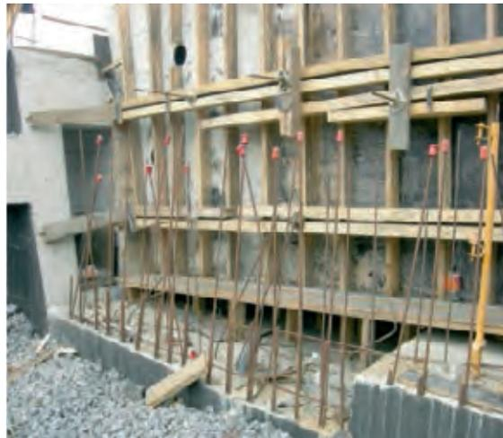
**Figura 3.5.2. Encofrado con paneles y tablones**
