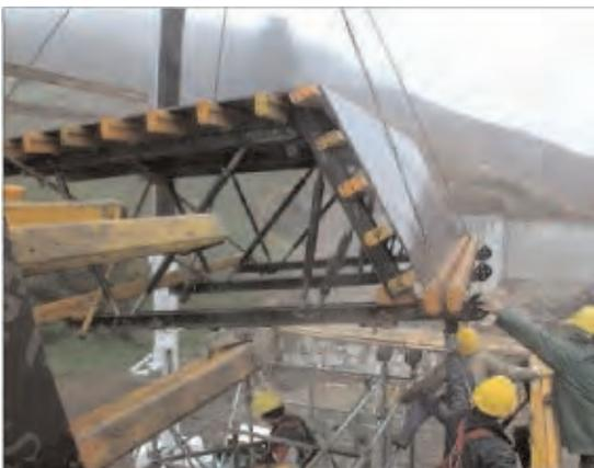
**Figura 3.5.3.5. Guiado del encofrado por el lado donde no existe riesgo de atrapamiento**
