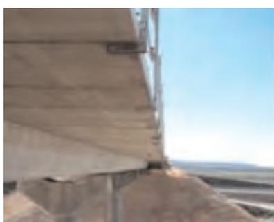
***Figura 3.6.42. Borde de tablero de vigas prefabricadas con barandilla colocada en las prelosas***
