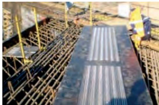
**Figura 3.1.10. Zona de paso con protección antideslizante, sobre armadura de losa con separación entre barras amplia**
