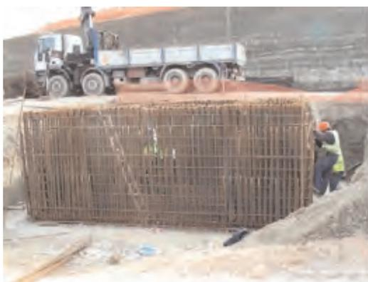
***Figura 3.6.29. Ejecución de ferralla in situ, en alzado***
