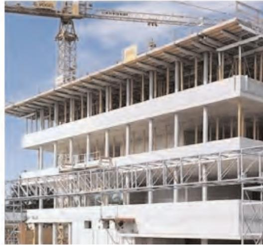
**Figura 3.5.3.77. Encofrado de forjados con vuelos**
