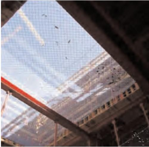
**Figura 3.5.3.76. Redes en encofrado horizontal para forjado**
