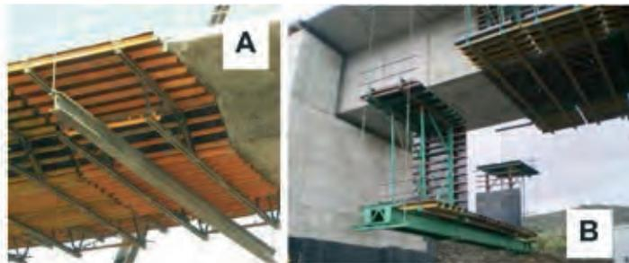
**3.5.3.82. Desmontaje de encofrado tipo barco mediante: A- viga soporte. B- bastidor auxiliar**
