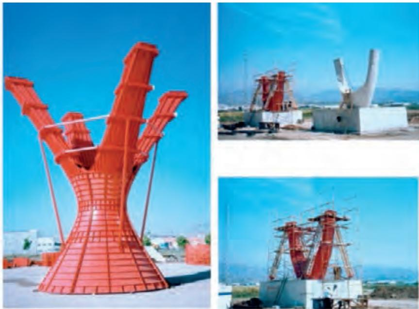
**Figura 3.5.5. Encofrados especiales para pilas de pasos superiores**
