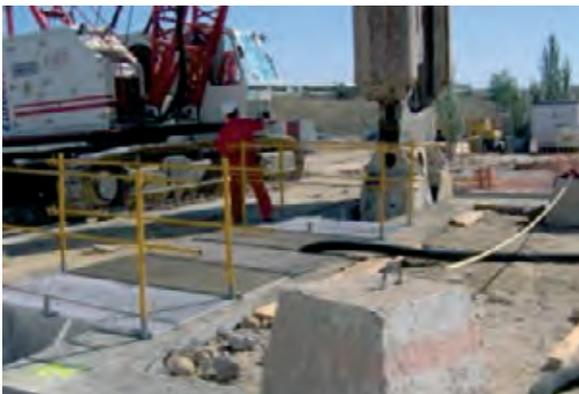
**Figura 3.1.5. Protecciones en la excavación.
