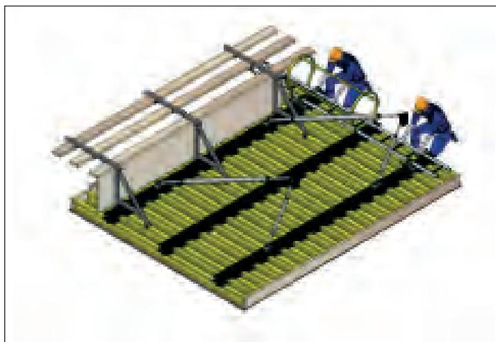
*Figura 3.5.3.19. Encofrado estandarizado a medida. Montaje de escalera tubular integrada en él*
