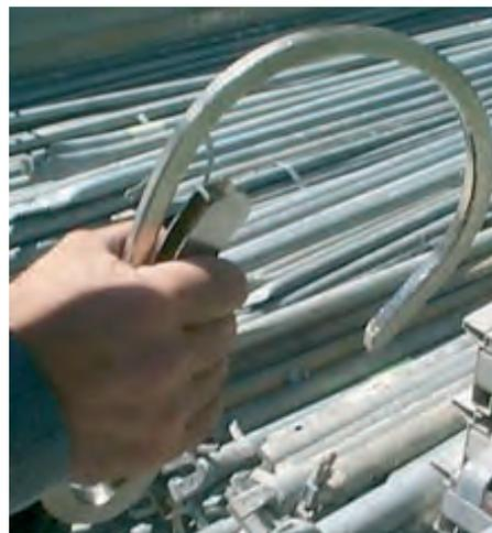
Figura 3.4.10. Revisión de elemento de elevación
