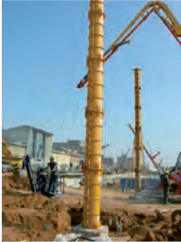
**Figura 3.5.3.27. Encofrado de pilar con estabilizadores (en montaje)**
