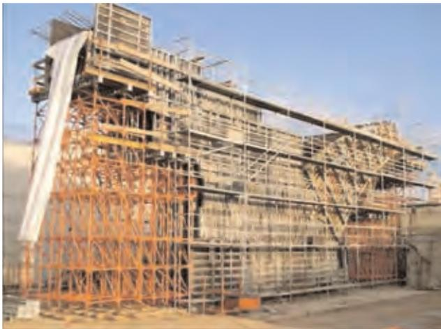
**Figura 3.5.14. Encofrado para gran elemento singular (pila de sección variable)**
