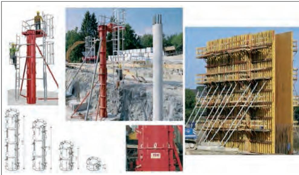
**Figura 3.5.1.1. Ejemplos de encofrados verticales**
