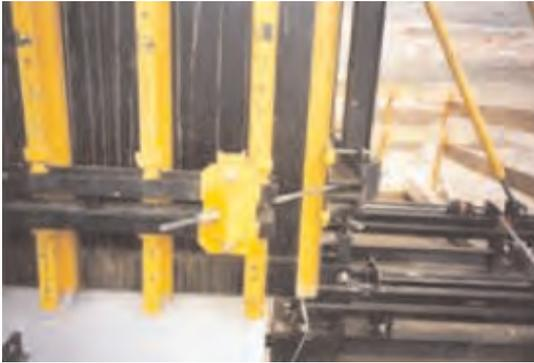
**Figura 3.5.3.63. Elementos de cierre de encofrado para pila**
