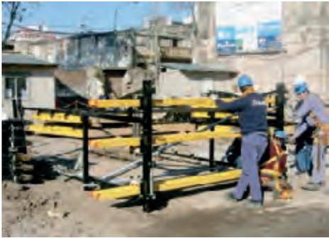
Colocación de las vigas de la plataforma principal que darán soporte al entablado de la misma
