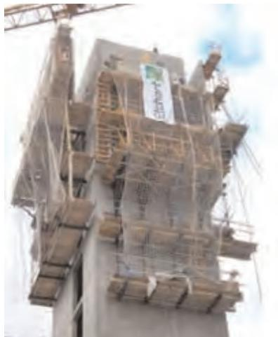
*Figura 3.5.3.66. Izado del sistema de trepa hasta los alojamientos del nivel superior*
