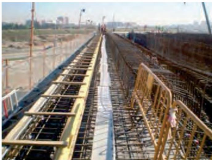
*Figura 3.1.11. Habilitación de zona de paso, sobre ferrallado de losa con separación entre barras amplia*
