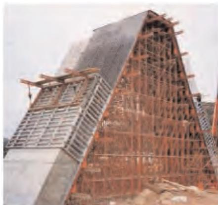
**Figura 3.5.6. Encofrado para alzado inclinado**
