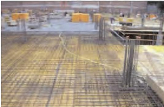
**Figura 3.6.36. Forjado unidireccional-losa**
