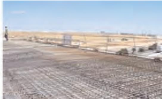
**Figura 3.6.39 Ferrallado de tablero de puente**
