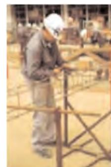
**Figura 3.6.13. Armado de ferralla**
