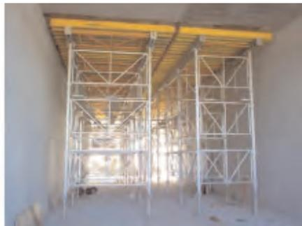
**Figura 3.5.3.68. Encofrado para losa**
