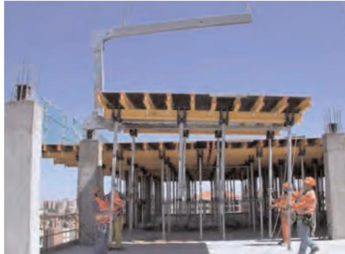
*Figura 3.5.2.7. Encofrado de mesas durante el montaje*
