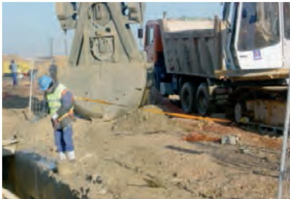
**Figura 3.1.3. Protecciones individuales para tareas de medición y comprobación de excavación**
