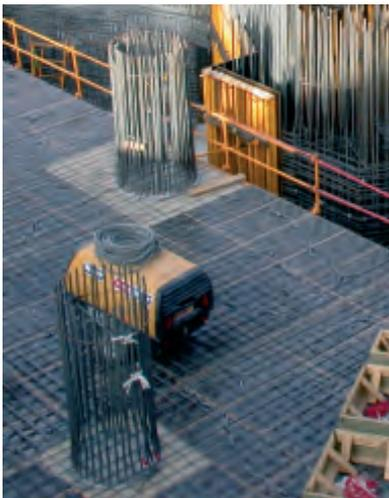
**Figura 3.5.3.20. Puesta en obra. Esperas para armaduras de pilar**
