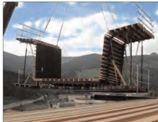
**Figura 3.5.3.4. Montaje de encofrado tipo barco con bastidor auxiliar y sin él**
