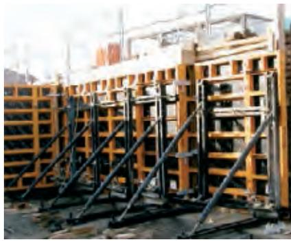
**Figura 3.5.3.35. Encofrado a una cara**
