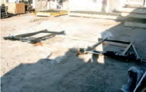
**Figura 3.5.3.48. Posicionamiento de consolas a la distancia establecida en los planos de montaje**
