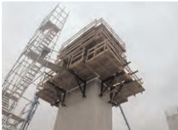
**Figura 3.5.3.65. Acceso a sistema trepante mediante escalera de andamio**
