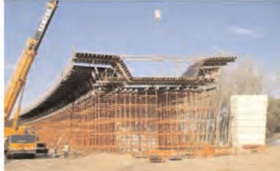
**Figura 3.5.3.73. Módulo de encofrado tipo barco**
