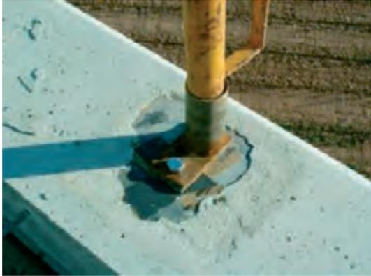
**Figura 3.1.7. Detalle de balaustre para protección de borde de alzado**
