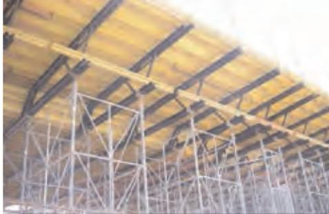
*Figura 3.5.3.1. Montaje de encofrado sobre cimbra*
