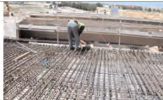
**Figura 3.6.41. Ejecución de ferralla en tablero de puente de vigas prefabricadas**
