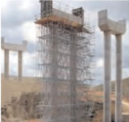
Figura 3.6.31. Ejecución de ferralla in situ, en pórticos
