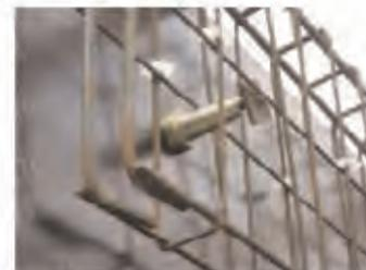
**Figura 3.5.3.55. Anclaje de trepa en espera. Detalle desde el interior del encofrado preparado para hormigonar**
