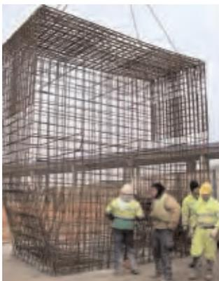
**Figura 3.6.24. Ferralla prefabricada lista para ser izada y colocada**
