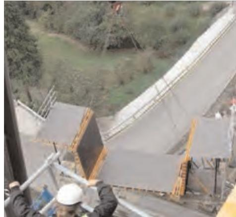
*Figura .3.5.3.2. Premontaje del encofrado para tablero de puente en el suelo e izado posterior*
