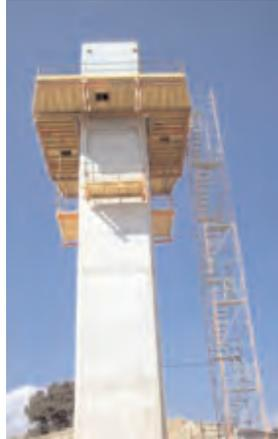
**Figura 3.5.3.42. Encofrado trepante con su acceso**
