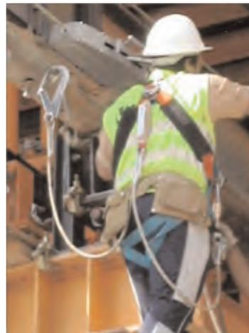
**Figura 3.5.3.8. Uso de EPI's: línea de vida y arnés con doble anclaje**
