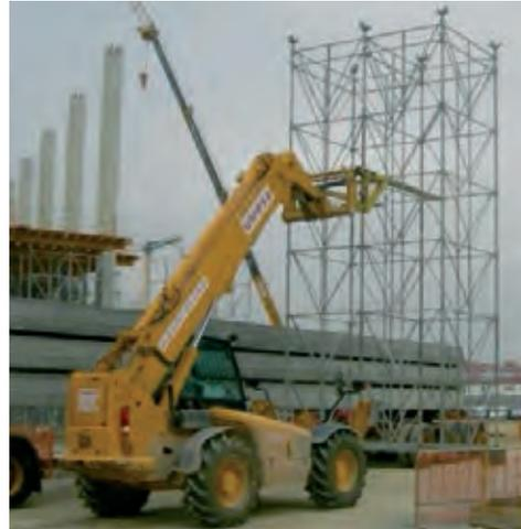
**Figura 3.4.4. Medios auxiliares para el montaje de cimbras**
