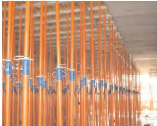
**Figura 3.5.3.75. Apeos para encofrado de forjado**
