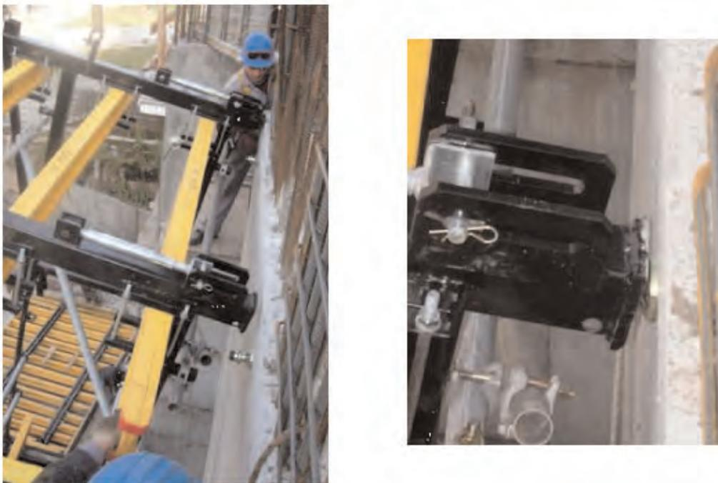
**Figura 3.5.3.57. Posicionamiento de la consola de trepa en los anclajes (la plataforma principal está sin entablar para que se observe este detalle). Detalle de introducción de la cabeza de la consola en el elemento de anclaje**
