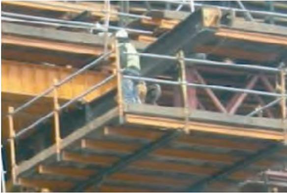
**Figura 3.1.12. Barandilla con tubos metálicos**
