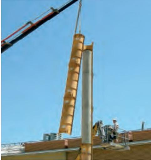
**Figura 3.5.3.37. Desencofrado de columna utilizando grúa y plataforma elevadora**
