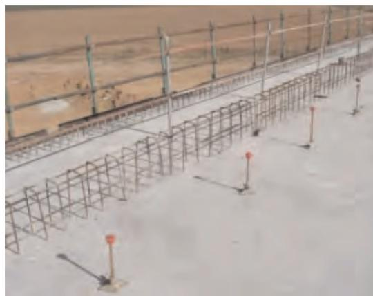
**Figura 3.5.3.40. Protección lateral colocada antes de desencofrar el tablero**
