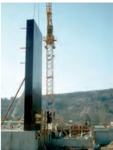
**Figura 3.5.3.29. Módulo de encofrado para muro (cara "primera")**
