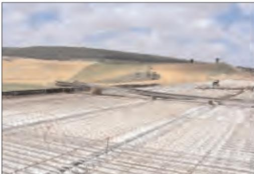
**Figura 3.6.40. Ferralla sobre prelosa prefabricada en tablero de puente de vigas prefabricadas**
