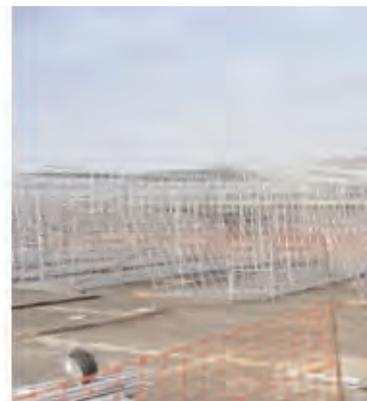
**Figura 3.6.26. Ferralla prefabricada acopiada**
