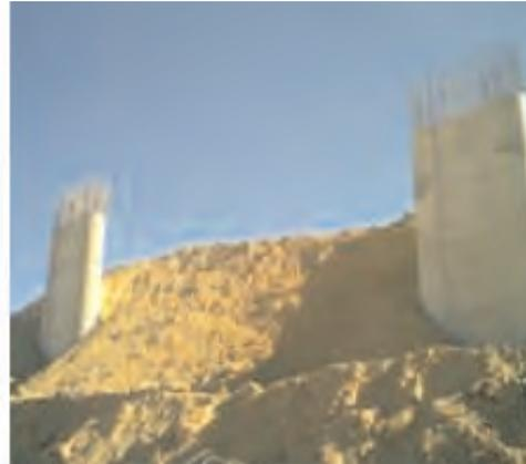
Figura 3.6.32. Ejecución de ferralla, in situ, en pilas
