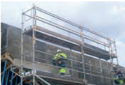
**Figura 3.1.9. Protecciones colectivas para facilitar el montaje de andamios**
