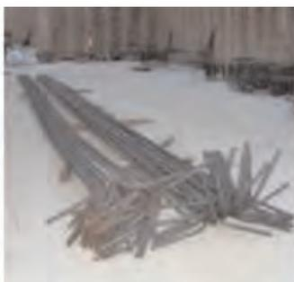
**Figura 3.6.9. Acopio de barras de ferralla acabadas con un extremo en escuadra**
