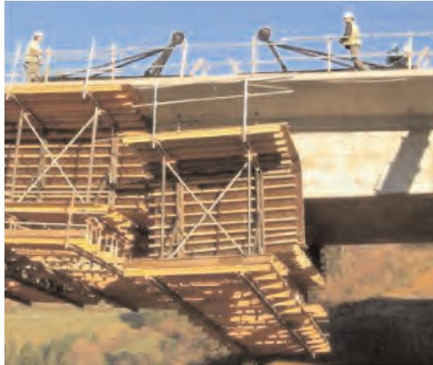
**Figura 3.5.3.80. Desmontaje de módulo de encofrado mediante cabrestantes**
