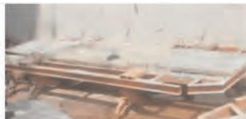
**Figura 3.5.3.60. Plataforma interior de trepa especial, parcialmente entablada**
