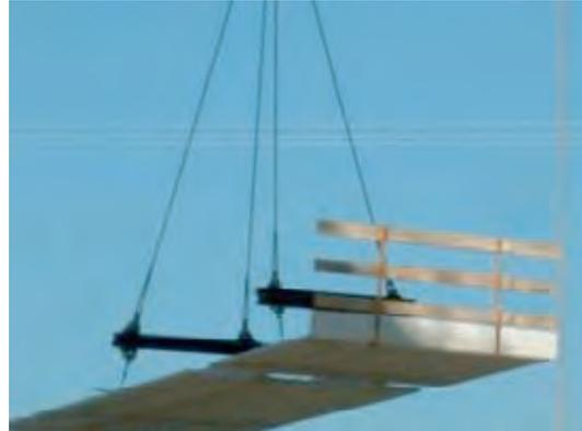
**Figura 3.1.2. Protecciones colectivas de bordes, colocadas previamente en los laterales de prelosas, evitando, así, riesgos en su colocación**
