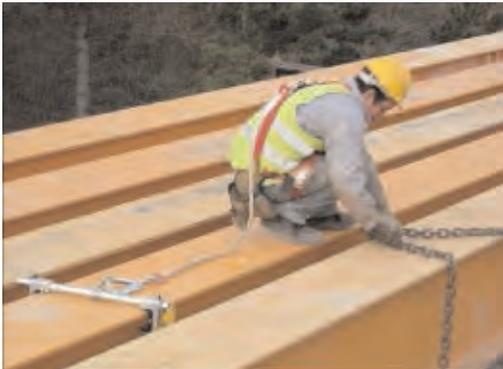
**Figura 3.5.3.7. Anclaje de arnés a elemento específico**
