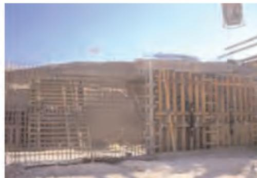
**Figura 3.6.28. Muro de sótano**
