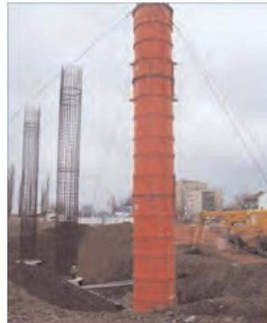
**Figura 3.5.15. Encofrado circular (pila)**
