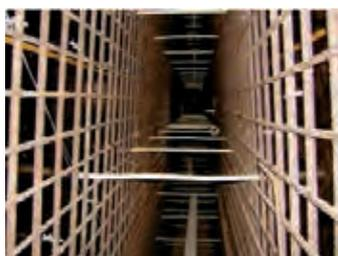
**Figura 3.5.3.30. Armadura con tubos de protección de las barras de amclaje y separadores**
