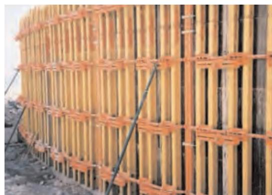
**Figura 3.5.4. Encofrado para elemento circular**
