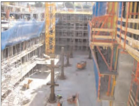
*Figura 3.5.3.9. Utilización de diversos encofrados en edificación*
