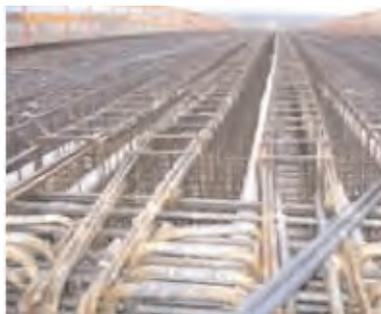
**Figura 3.6.43. Tablero insitu con vainas de pretensado**
