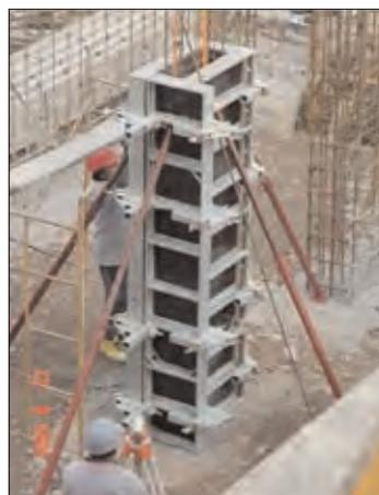
**Figura 3.5.11. Encofrado para pilar**
