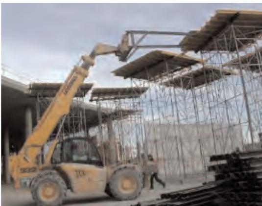
**Figura 3.5.3.83. Desmontaje de partes de encofrado mediante manipuladora**
