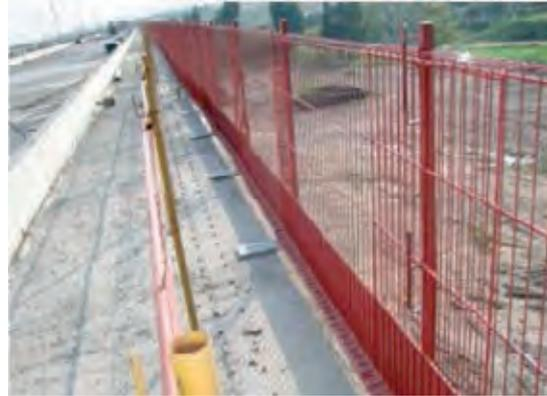
**Figura 3.1.8. Protecciones colectivas de borde de alzado para las diferentes fases de ejecución**
