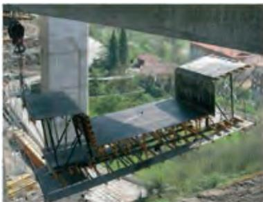
**Figura 3.5.3.81. Desmontaje mediante 2 grúas**
