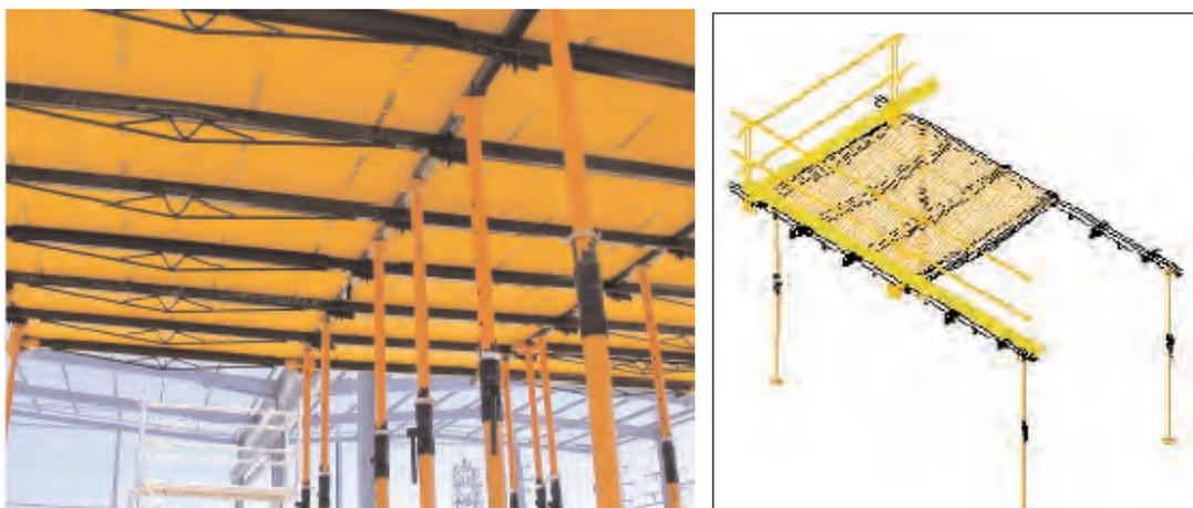
**Figura 3.5.2.2. Encofrado tipo mecano**
