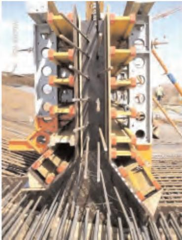
**Figura 3.5.3.74. Encofrado para alma o tabique**
