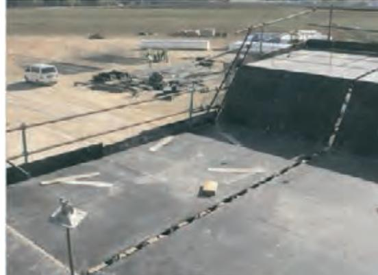
**Figura 3.5.3.14. El último tramo de encofrado se monta con las protecciones frontales colocadas antes del izado**
