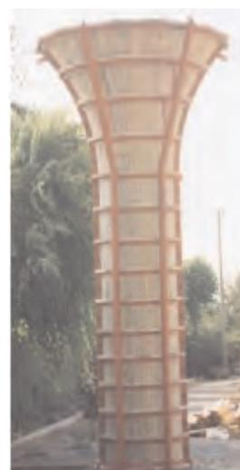
**Figura 3.5.7. Encofrado especial para pilas de puentes**
