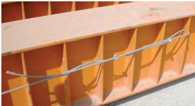
**Figura 3.1.15. Línea de Vida incorrectamente montada. No tiene guardacabos metálico, falta un grillete, la separación entre grilletes es incorrecta y existe un bucle**
