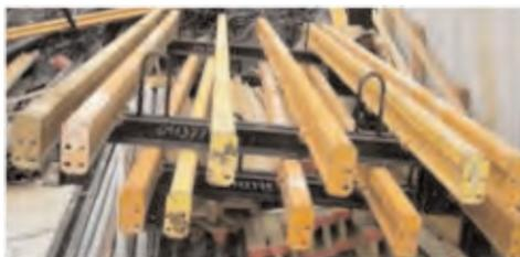
**Figura 3.5.3.59. Plataformas interiores de trepa realizadas con material estandar antes de ser entabladas**
