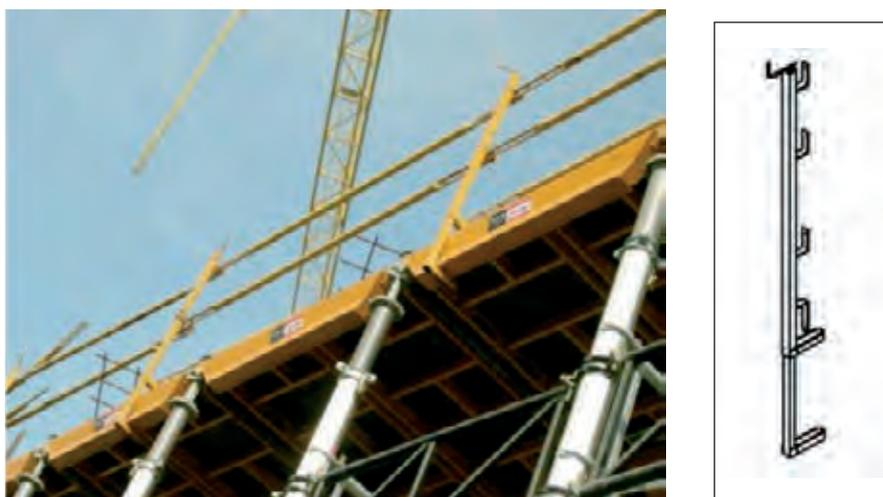
**Figura 3.1.1.6. Sistema de fijación a forjado mediante mordaza.**
