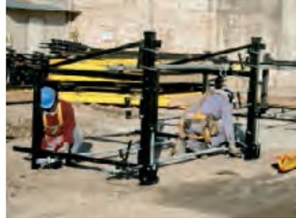
**Figura 3.5.3.49. Colocación de elementos de arriostramiento entre consolas**
