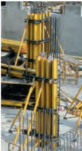
**Figura 3.5.3.24. Encofrado de pilar con estabilizadores**
