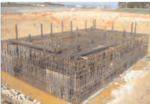
**Figura 3.6.27. Armadura de zapata montada in situ**
