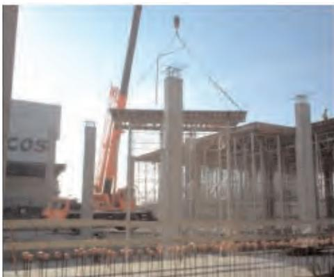
**Figura 3.5.3.69. Montaje del módulo de encofrado**
