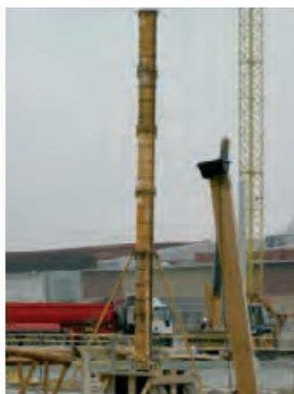
**Figura 3.5.3.25. Encofrado de pilar con estabilizadores y vientos**
