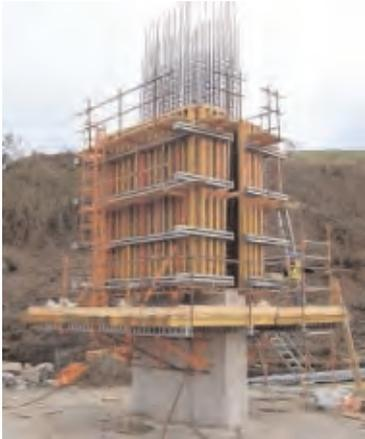
**Figura 3.5.3.41. Encofrado trepante**
