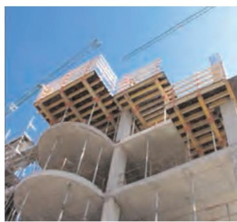
**Figura 3.5.12. Encofrados con protecciones laterales**
