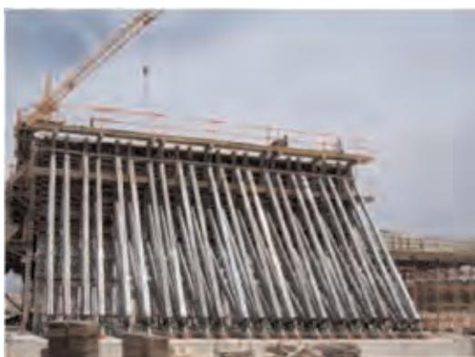
**Figura 3.5.3. Encofrado vertical apuntalado**
