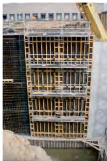
**Figura 3.5.3.31. Encofrado de muro colocado en la cara "opuesta"**
