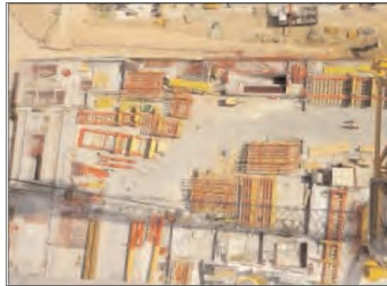
*Figura 3.5.3.10. Acopio de encofrados en obra de edificación*
