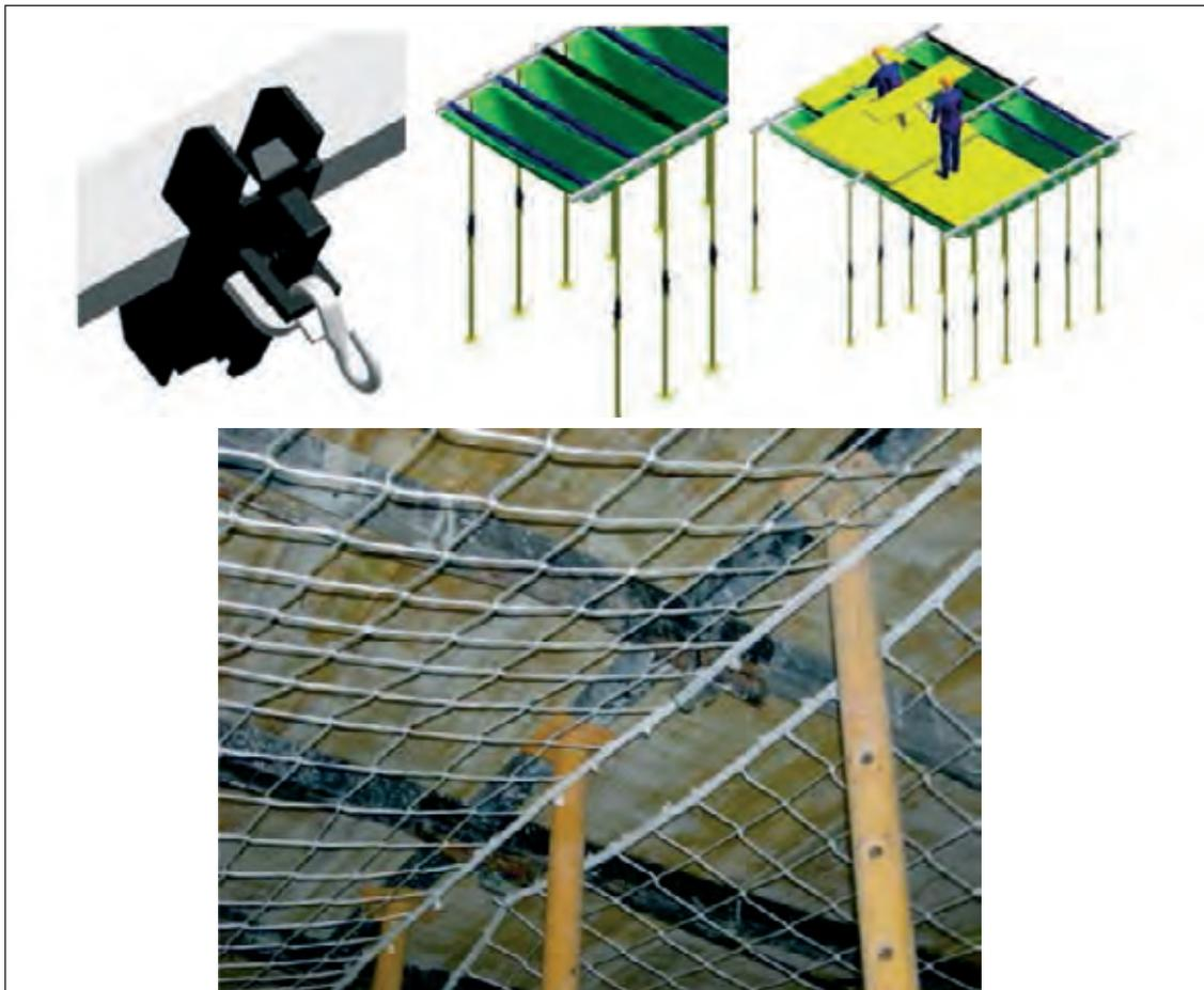
**Figura 3.1.1.19. Red bajo forjado con ganchos en "s" sobre cabezal recuperable**
