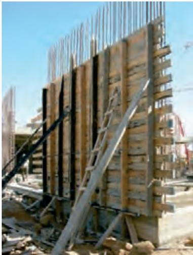
**Figura 3.5.1. Encofrado tradicional con tablas y tablones**
