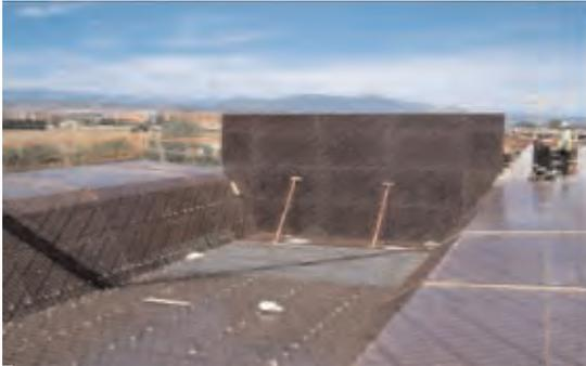
**Figura 3.5.3.72. Encofrado tipo barco**
