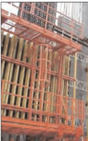
**Figura 3.5.10. Módulo de encofrado con escaleras entre plataformas**
