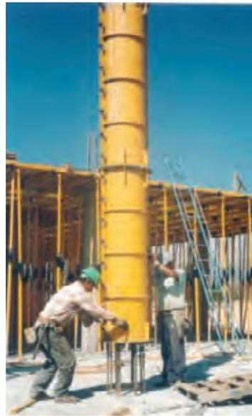
**Figura 3.5.3.23. Posicionamiento del encofrado de un pilar circular**
