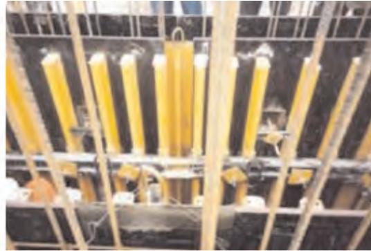
**Figura 3.5.3.64. Detalle de encofrado interior de pila donde se observan tapes y encajes que servirán de soporte para la siguiente trepa**
