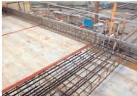
**Figura 3.6.34. Ferralla de vigas perimetrales de forjado**
