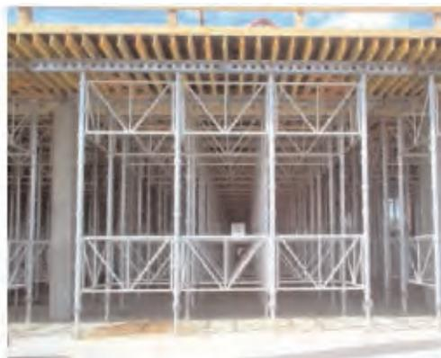
**Figura 3.5.3.70. Módulos de encofrado**
