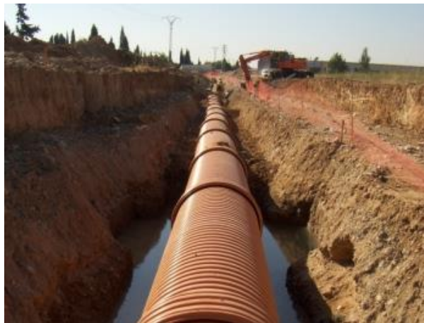
Figura 8. Tubería corrugada de PVC SN8 SANECOR
