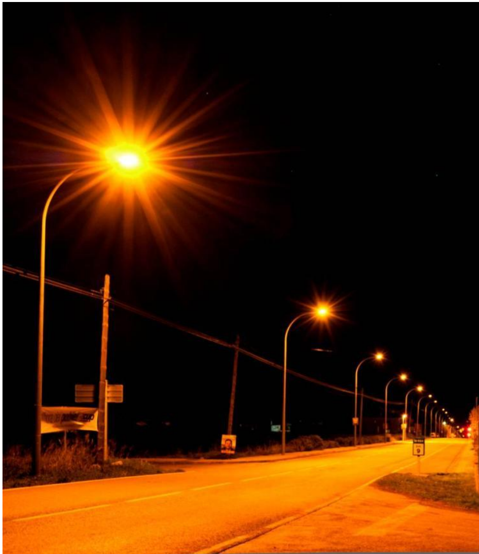
Ilustración 7. Iluminación Santa Pau
