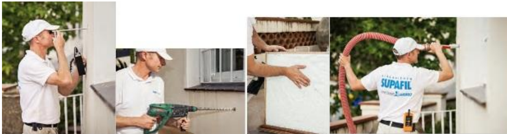
Imagen 6. Proceso rehabilitación energética fachadas mediante insuflación mecánica de Lana Mineral: inspección cavidades, perforación puntos de insuflación, muestra material aislante, insuflado cámaras de aire
