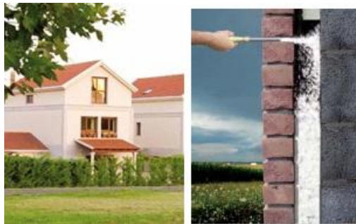
Imagen 10. Insuflación cámara de aire muros cerramiento fachadas con Lana Mineral virgen
