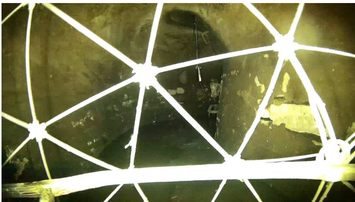
Ilustración 2. Inspección de colector unitario en San Sebastián - Donostia
